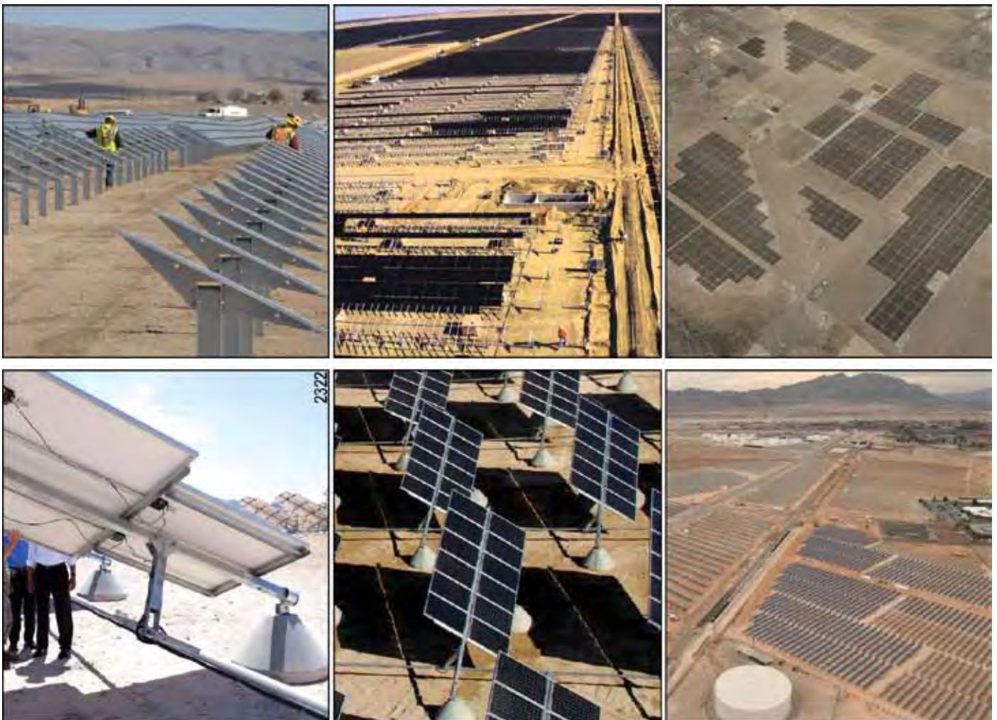
2322. Proyecto Topaz Solar (arriba). Esta planta solar se inauguró en 2014 con 550 MW de potencia y estimado de 1.100 GWh de energía (factor de capacidad del 23%). Las celdas son de telurio de cadmio (FirstSolar). Se encuentra dentro de un hábitat crítico con decenas de especies protegidas (p.e., rata canguro gigante y zorro de San Joaquín). Para evitar litigios se adquirió 70 km 2 y se declararon en conservación a perpetuidad. Topaz se diseñó para funcionar como hábitat de vida silvestre durante 35 años. Puede beneficiar a los zorros proporcionando refugio de los depredadores y lagunas pequeñas en el vallado alrededor del sitio. En otros proyectos se verificó que aves acuáticas aparecieron muertas y se especula que están confundiendo la luz polarizada que se refleja en los paneles con las lagunas donde se sumergen. El Proyecto Nellis Solar (abajo). Esta planta se inauguró en 2007 en Nevada (Estados Unidos) con 14 MW de potencia y 32 GWh/año de energía para la base militar vecina (aporta el 23% de la energía consumida). Ocupa 57 ha y utiliza un sistema de seguimiento solar mediante barras que interconectan los juegos de paneles solares. La empresa constructora (SunPower) vende la energía a la base militar a una cuarta parte que la empresa eléctrica tradicional (0,022 us$/kWh), pero la provisión es sin almacenamiento para los momentos críticos. La energía entregada fluctúa entre 1 GWh en enero y 4 GWh en julio.
