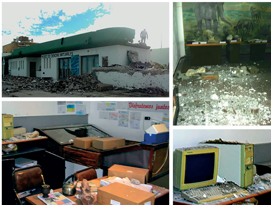
Figura 10- Demolición del Museo de Monte Hermoso.
