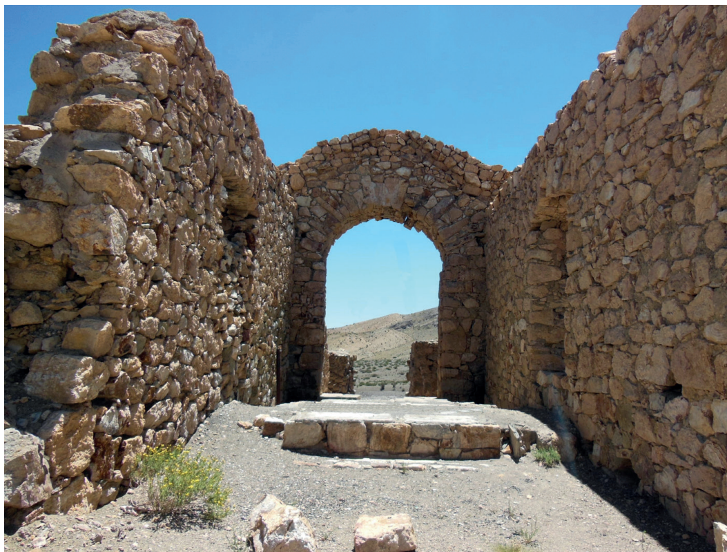
Figura 9 - Construcciones del distrito minero de Paramillos de Uspallata, provincia de Mendoza, actualmente en ruinas.
